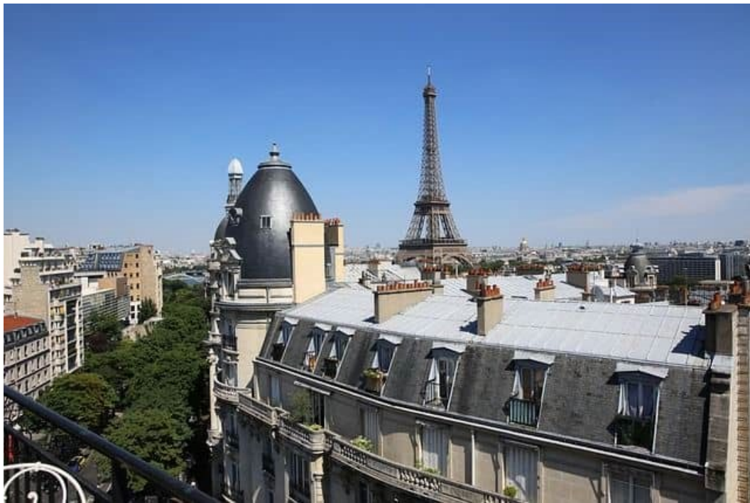
Toiture parisienne en zinc avec brisis et terrasson. Le brisis est la partie pentue avec les fenêtres tandis que le terrasson est la partie plus plate avec les cheminées. La séparation entre les deux s'appelle la ligne de brisis. © Pixabay - pmadelenat
