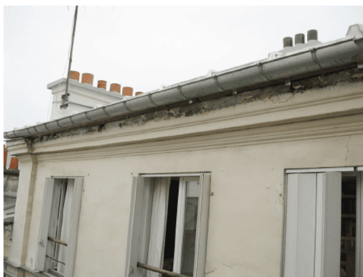
18 rue Caffarelli (Paris 3 e ) avant rénovation de la toiture : la gouttière repose directement sur la corniche.
