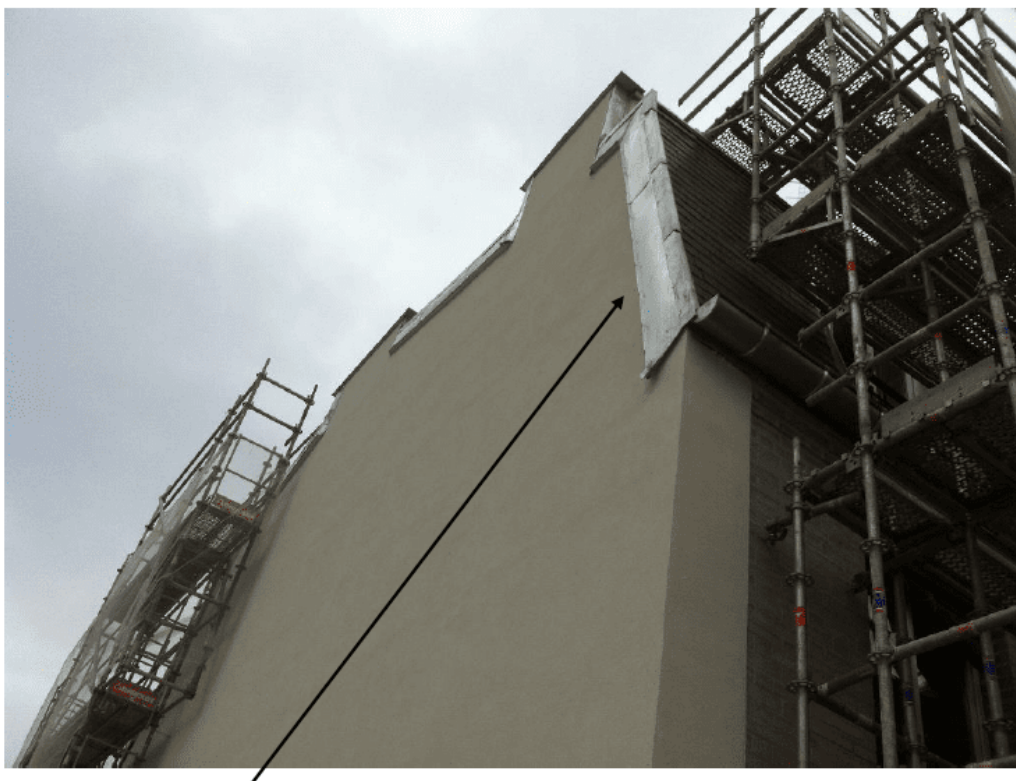
Bande de rive plus haute, du fait de l'épaisseur de l'isolant ci-dessous (SDC 18 Championnet 75018)
