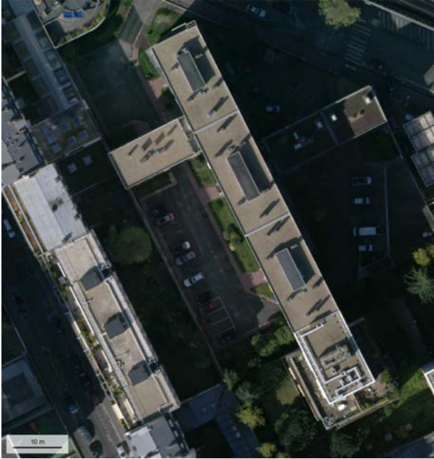
Dans le bâti moderne et en milieu urbain dense, une partie des stationnements s'organise en pied d'immeuble, Paris 15 e .
