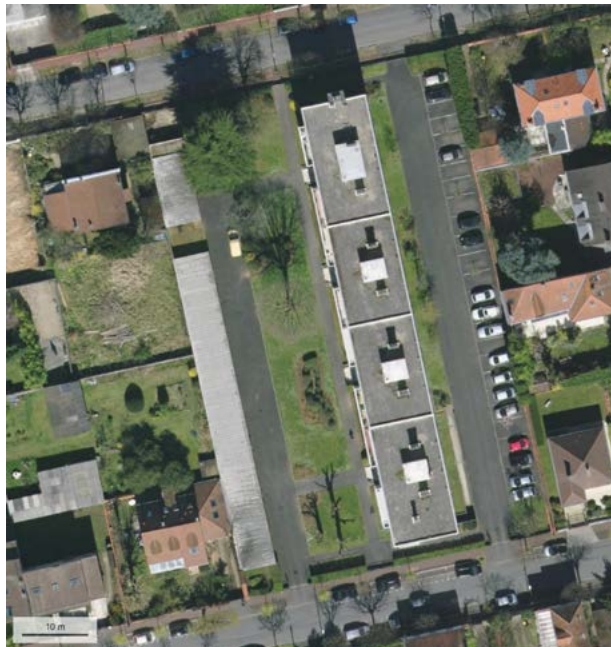
Dans le bâti moderne et en milieu urbain moins dense, le stationnement s'organise en pied d'immeuble en plus d'autres fonctions (circulation, espaces verts) sur les espaces disponibles, Saint-Maur-des-Fossés (94).
