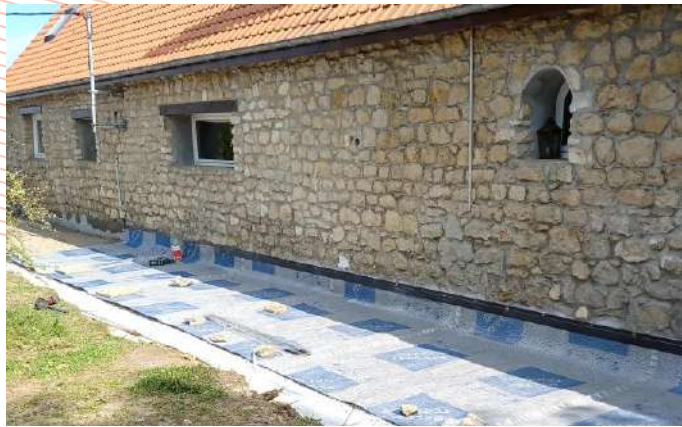
Géomembrane avec une tranchée drainante
