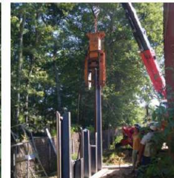
Écran métallique placé à une distance minimale de 4 m de l'arbre
