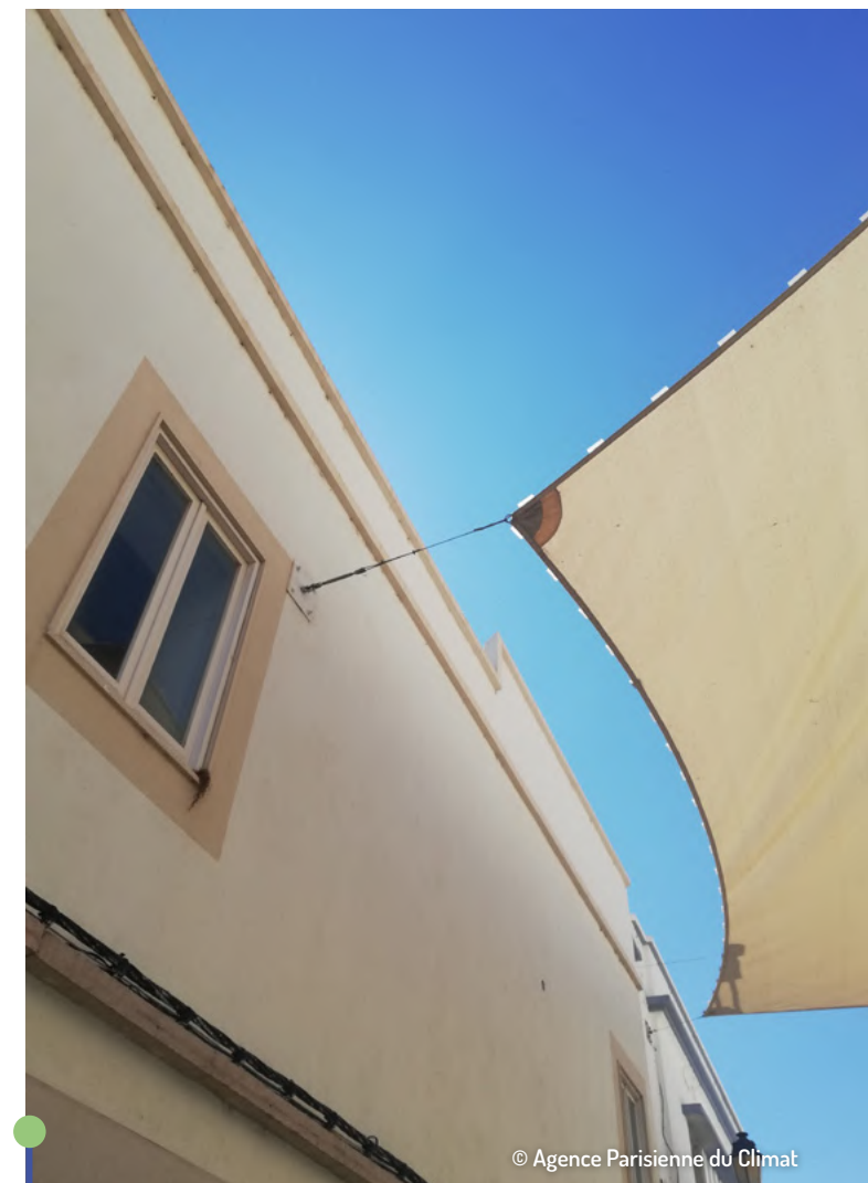
À Faro, les voiles d'ombrage sont fixées via des plaques de métal vissées aux bâtiments
