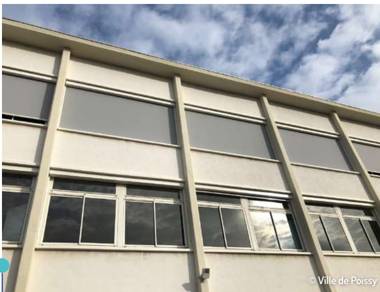
Vues des stores ZIP extérieurs installés par la ville de Poissy
