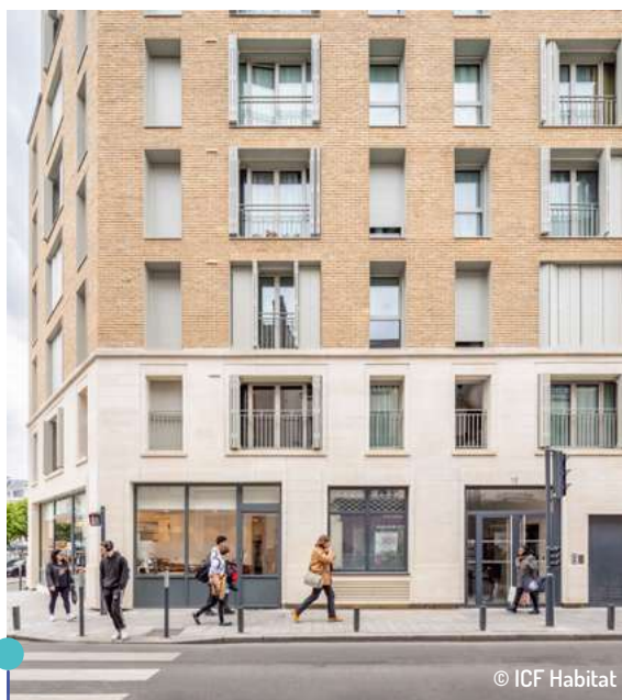
À Enghien-les-Bains (95), des volets roulants blanc en PVC, couleur permettant de ne pas stocker la chaleur, ainsi que volets pliants accordéon sur les plus grandes fenêtres
