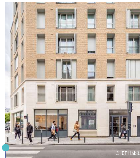
À Enghien-les-Bains (95), des volets roulants blanc en PVC, couleur permettant de ne pas stocker la chaleur, ainsi que volets pliants accordéon sur les plus grandes fenêtres
