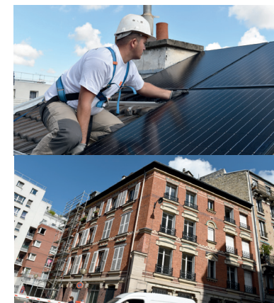
L'immeuble, ses façades en briques et installation des panneaux photovoltaïques en toiture. © CFT Concepts
