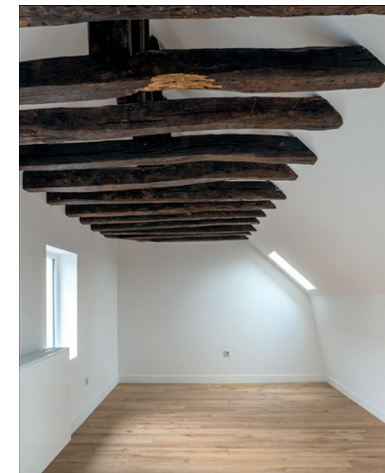
Intérieur d'un appartement du dernier étage et ses éléments visibles de charpente d'origine. © atelier MG
