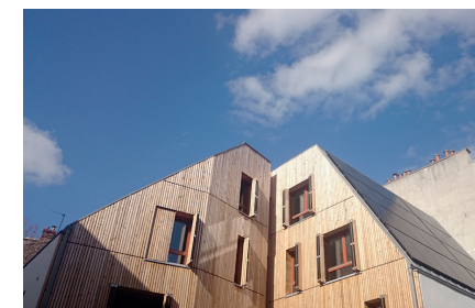
Vue sur le bardage bois à claire-voie, les ouvrants performants et sur la droite les capteurs photovoltaïques © Fabrice Fouriaux
