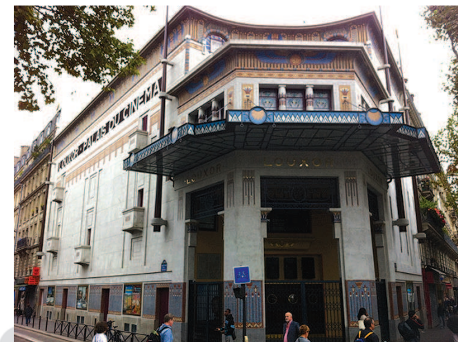
Façade du Louxor et ses mosaïques totalement rénovées © Rodolphe Donne
