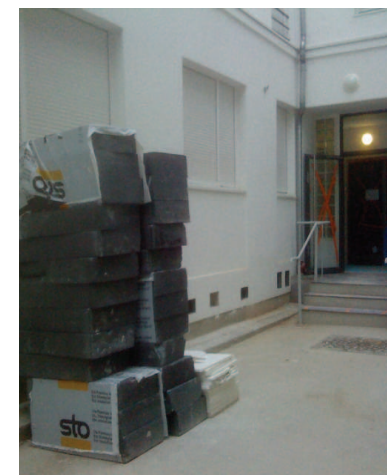
Gros plan sur les panneaux isolants pour l'isolation thermique extérieure © Fabrice Fouriaux
