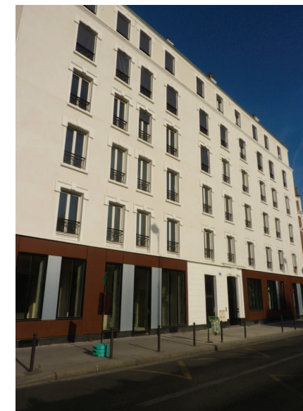
Façade rénovée, modénatures conservées avec ouvrants performants et stores en guise de protection solaire. © Fabrice Fouriaux
