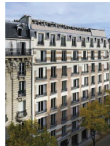
Vue sur la façade de l'immeuble après travaux et surélévation © Equateur architecture Luc Boegly
