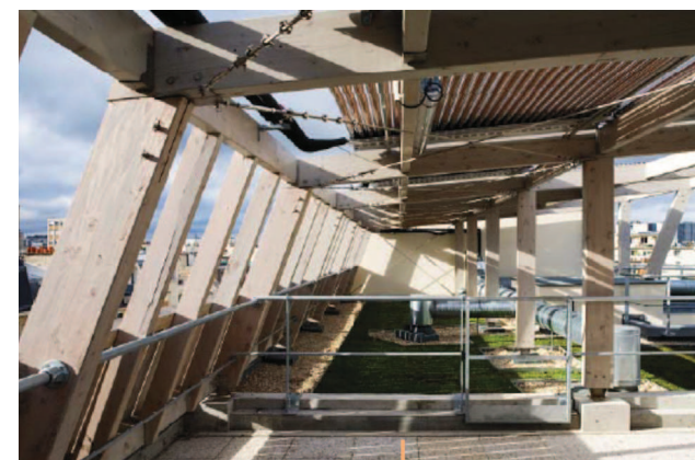
La terrasse abritée de l'étage surélevé, qui soutient les panneaux solaires © Equateur architecture
