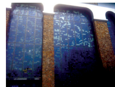
La façade, ses grandes ouvertures vitrées et leurs mosaïques photovoltaïques © Fabrice Fouriaux
