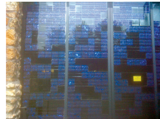
Gros plan sur la mosaïque de cellules photovoltaïques en façade © Fabrice Fouriaux
