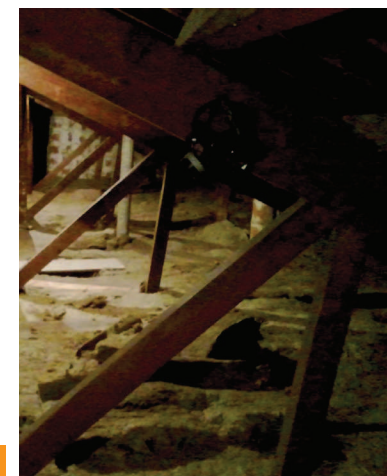
Rouleaux de laine de roche posés sur le plancher des combles © Gaëtan Brispierre
