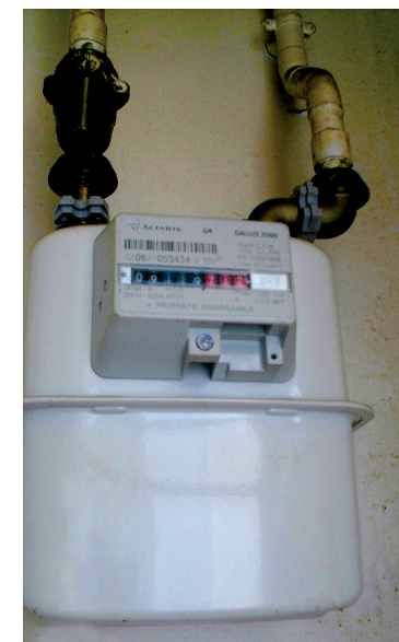
Compteur gaz et son index permettant de relever et mesurer les mètres cubes consommés. © Agence Parisienne du Climat
