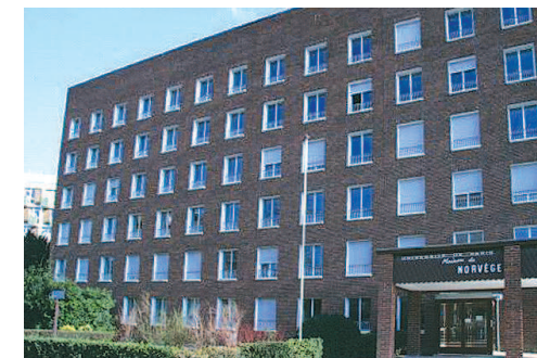
Façade du bâtiment préservée : briques rouges, ouvrants performants et volets roulants © CIUP
