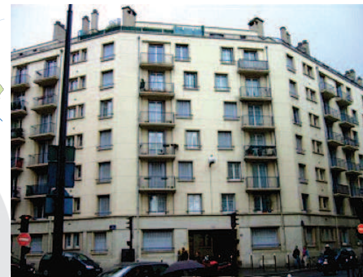
Vue sur la façade dont les murs seront isolés par l'extérieur, contribuant ainsi à l'excellente performance énergétique finale. © ICF Habitat
