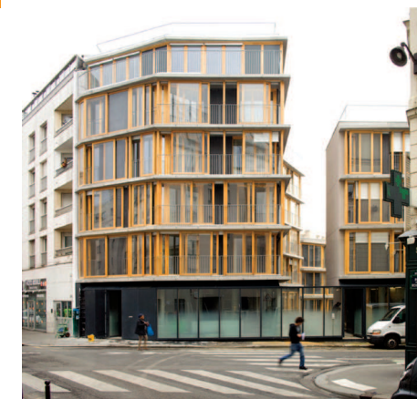
Vue sur façade avec ses vastes ouvertures laissant apparaître les murs capteurs en transparence. © Clément Guillaume
