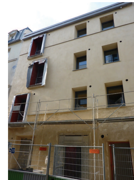
Façade du 25 rue Bourgon, en cours de finition. © Fabrice Fouriaux
