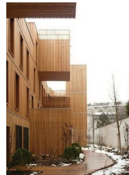
Vue sur la cour intérieure avec murs bardés à claire-voie en mélèze non traité. © Margaux Darrieus / AMC
