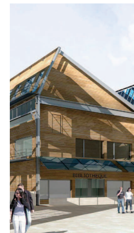
Vue depuis le Nord de l'esplanade © Jourda architecte Paris
