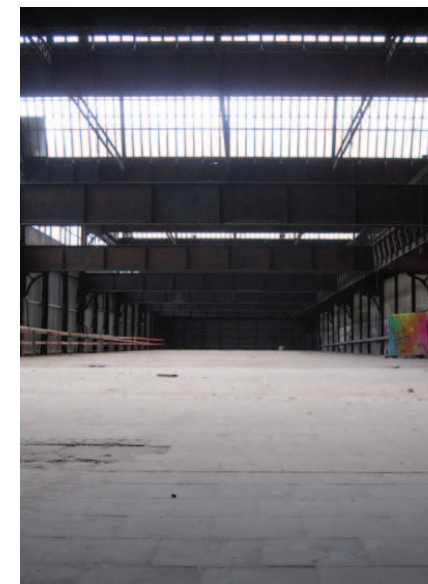
Vue de l'intérieur avant réhabilitation © URCAUE
