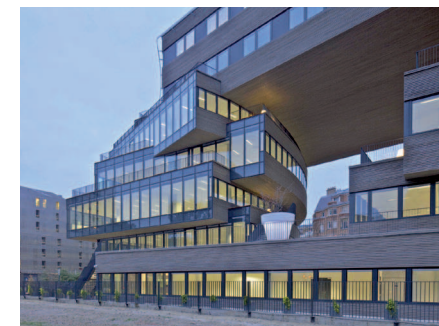
Vue sur façade sud bioclimatique « éclatée » laissant la lumière traverser le corps du bâtiment © North By Northwest Architectes
