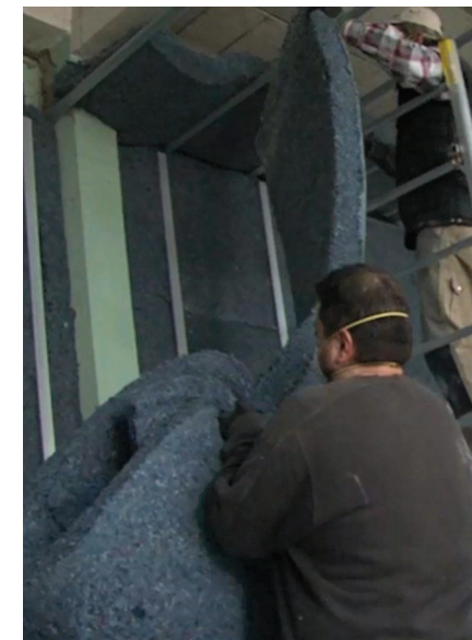
Pose de l'isolant métisse sur les murs et plancher haut. © Edif
