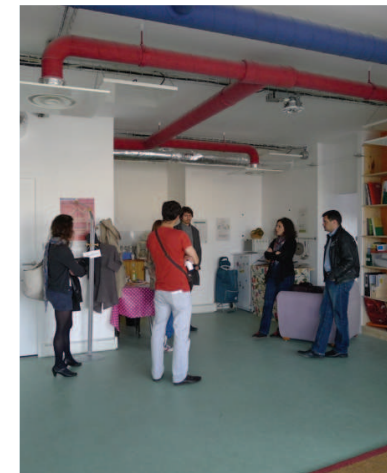
Zone ERP / appartement témoin / centre de documentation et ventilation double flux apparente. © APC
