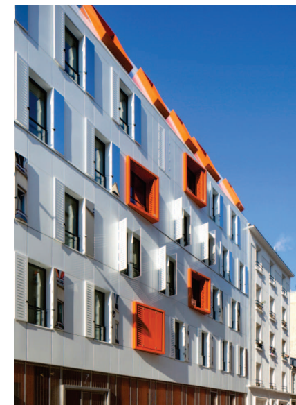
La façade damier sur rue : vêtue couvrant l'Isolation Thermique répartie et menuiseries mixtes bois-alu. © Luc Boegly
