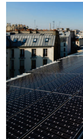
Panneaux solaires photovoltaïques au premier plan, thermiques au second © Luc Boegly
