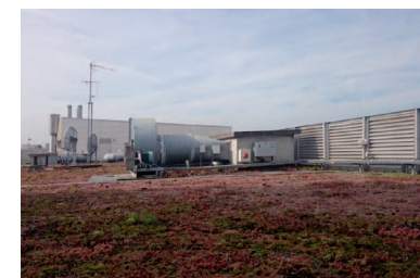
Toiture terrasse végétalisée de type extensif. Plusieurs avantages parmi lesquels le confort thermique nettement accru © Fabrice Fouriaux
