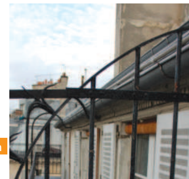
Quelques rafraîchissements s'imposent, l'énergie y sera intégrée, pour une rénovation « combinée » ! © M. Hardy
