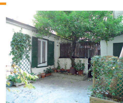
Rez-de-jardin sur lequel s'érigera la surélévation © Lanlo & Partenaires Architectes
