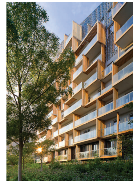
Façade sud-ouest, ses balcons à rupteurs de ponts thermiques et ses ouvrants performants. © Sergio Grazia
