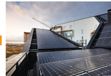
Vue sur une partie des 953m 2 de capteurs photovoltaïques « courants » en toiture. © Sergio Grazia
