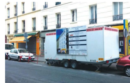
Photo de la façade rue avec la base vie pour les travaux © Paziaud
