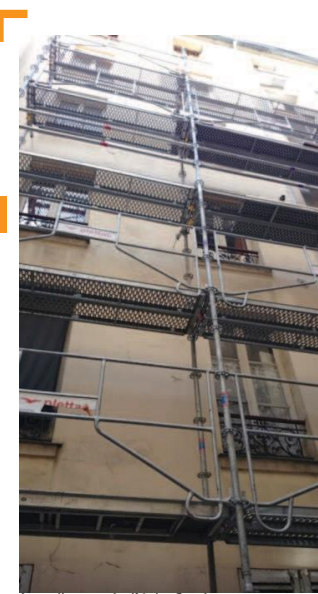
Installation de l'échafaudage au niveau de la façade sur cours © Carine Nicolas
