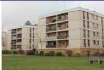
AVANT TRAVAUX Source REANOVA
